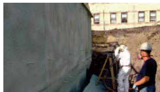
Nopová fólie se instaluje při zasypávání mezi zeminu a pěnovou izolaci.
