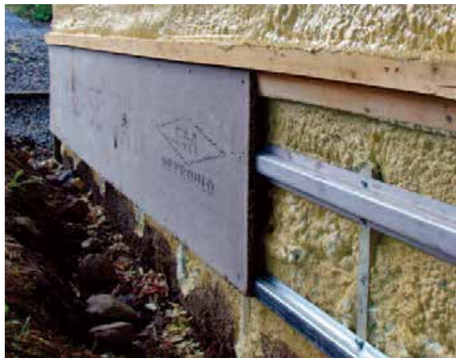
Ukázka instalace na nadzemní část základového zdiva během výstavby.
