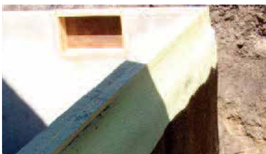
Bitumenový nátěr nanesený přímo na pěnu.
