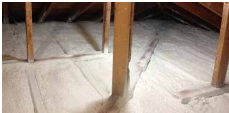
Dans le cas d'une toiture avec grenier ou d'un toit plat, le produit peut s'appliquer de l'intérieur du vide sous toit, directement sur le revêtement intérieur ou sur la finition du plafond. Le vide sous toit sera alors ventilé et non chauffé.
