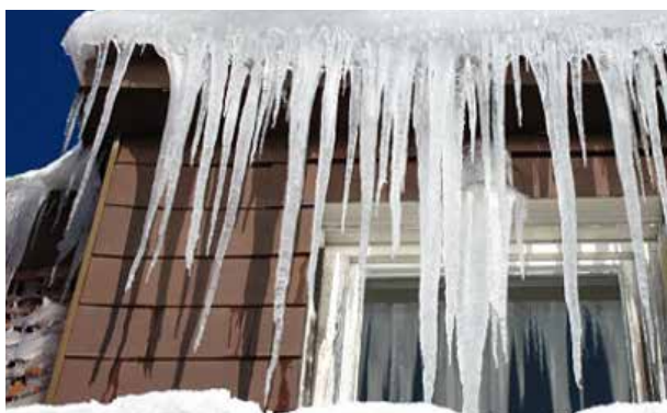
Les toits de ce type sont souvent la source de problèmes, aussi bien à l'intérieur de la structure que dans les matériaux. La cause réside souvent dans une mauvaise isolation et/ou une défaillance du système de pare-air
