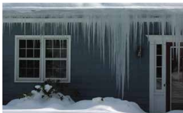
Les toits de ce type sont souvent la source de problèmes, aussi bien à l'intérieur de la structure que dans les matériaux. La cause réside souvent dans une mauvaise isolation et/ou une défaillance du système de pare-air
