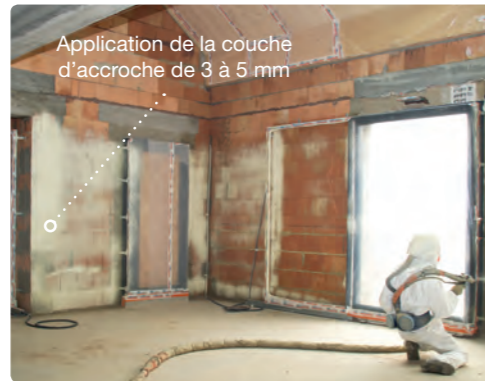
3/ Mur : réalisation de la couche d'accroche
