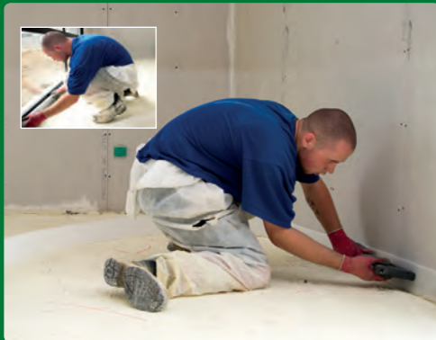
10/ Sol : pose de la bande périphérique
