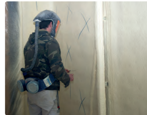
9/ Mur : mesure des épaisseurs
