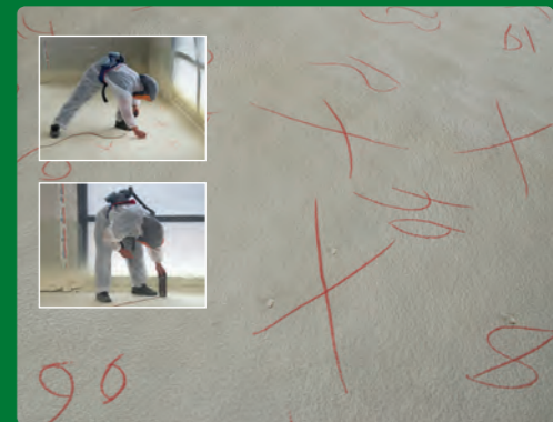
5/ Sol : mesure des épaisseurs
