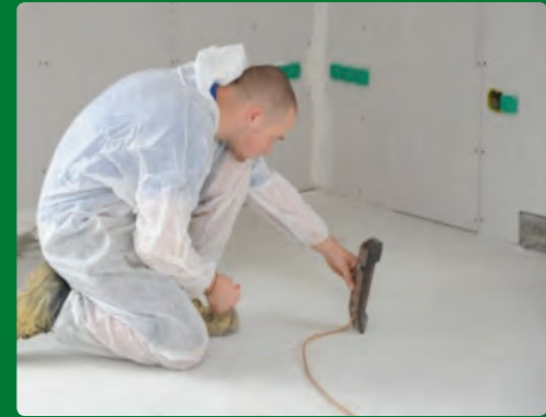
1/ Sol : vérification des niveaux
