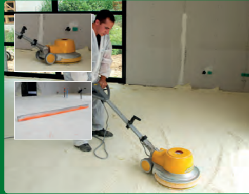
7/ Sol : surfaçage par ponçage
