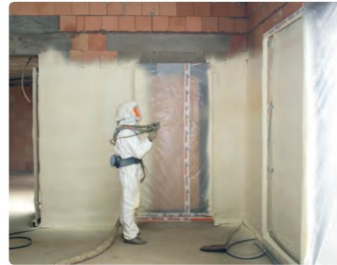
6/ Mur : projection des couches successives
