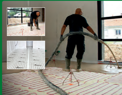
11/ Sol : coulage de la chape de finition
