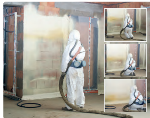
3/ Mur : réalisation de la couche d'accroche
