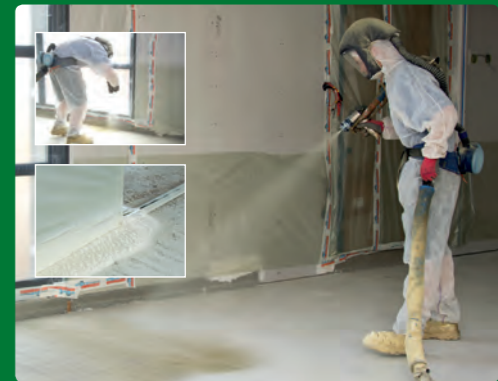
3/ Sol : réalisation de la couche d'accroche
