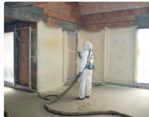
10/ Mur : projection de la couche de finition
