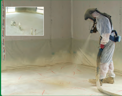
6/ Sol : projection de la couche de finition
