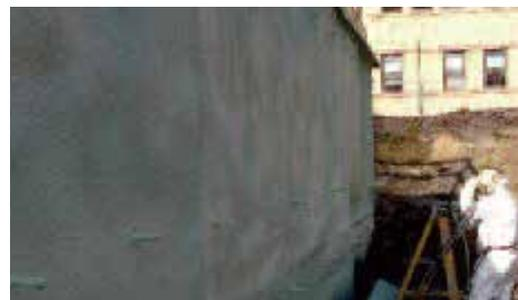
*Membrane de drainage qui sera soulevée devant la mousse lors du remblayage du sol.*
