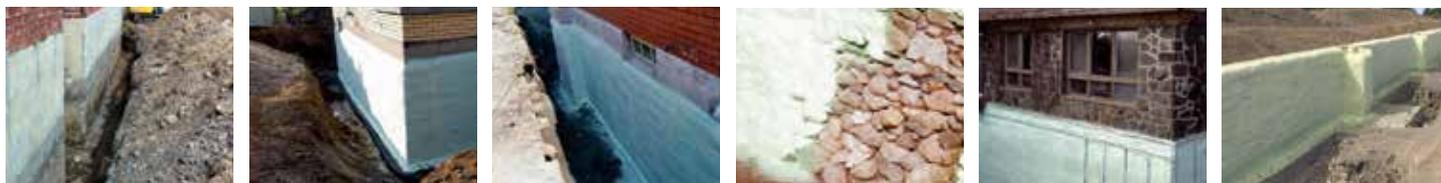
*La mousse projetée à cellules fermées HBS est idéale pour isoler par l'extérieur les anciennes fondations en béton ou en pierre.*
