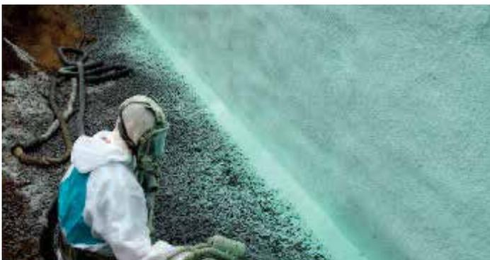
Le moment idéal et la façon la plus efficace d'isoler et d'imperméabiliser la fondation est de le faire par l'extérieur pendant l'excavation d'une fondation existante et avant de remblayer une nouvelle fondation. Cela crée une étanchéité parfaite entre la semelle et le mur.
