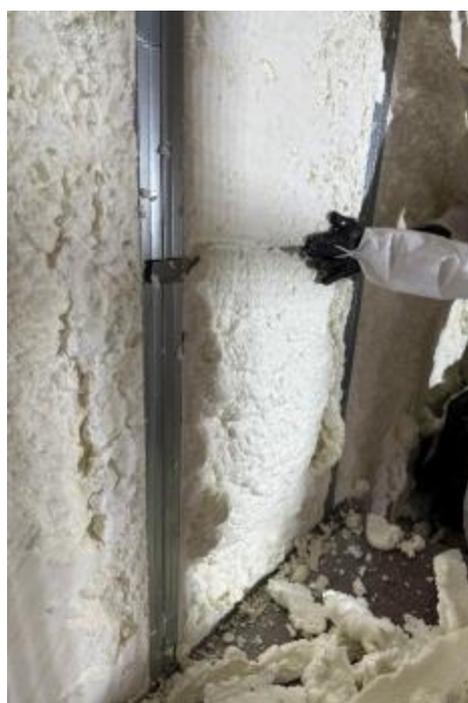
**Figure 2 – Mise en œuvre par découpe de la sur-épaisseur**
