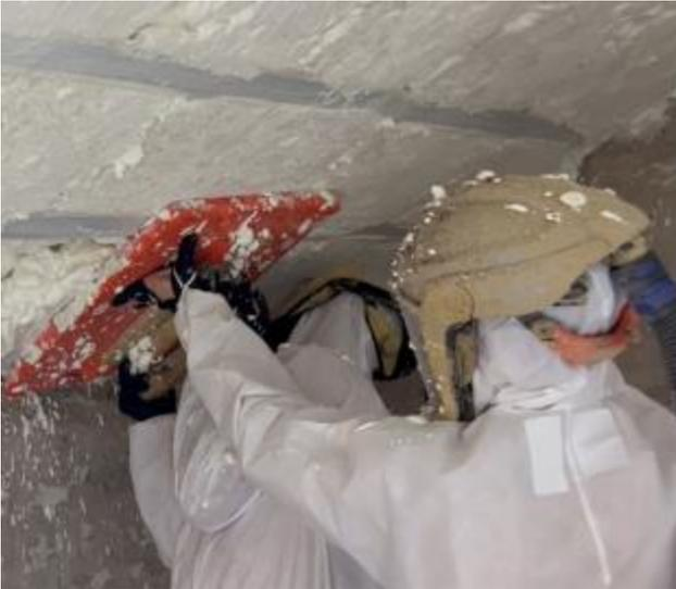
**Figure 2 – Mise en œuvre par la technique du « bouclier »**
