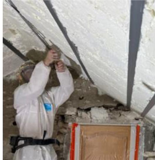
**Figure 3 – Mise en œuvre par découpe de la sur-épaisseur**
