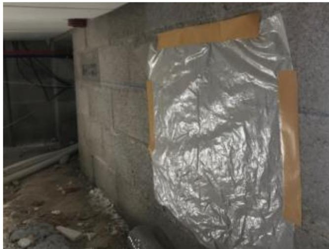
**Figure 5 : Protection des orifices de ventilation**
